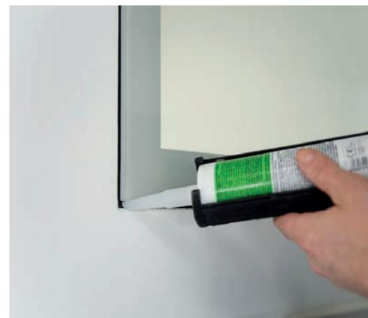
L'installation des panneaux vitrés peut être effectuée à la fin de la période de construction, afin de minimiser ainsi les risques d'endommager le verre. Il suffit alors d'introduire les panneaux vitrés parfaitement ajustés et de les fixer dans le châssis avec le système de verrouillage protégé. Enfin, il faut remplir de silicone le joint périphérique de 5 mm de large.
