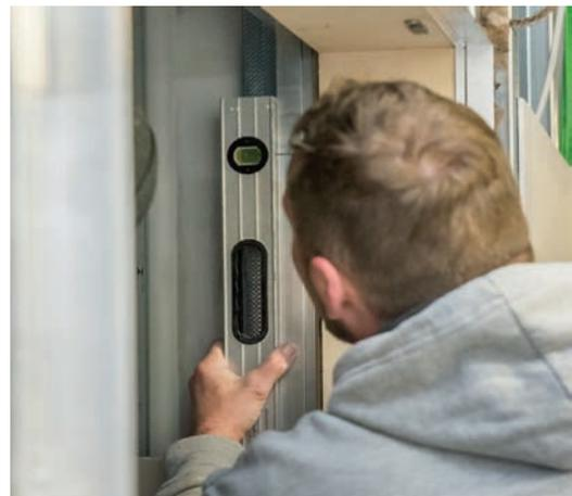
Le montage du châssis du système Planline dans placo se fait parallèlement à la construction de la cloison sèche.
