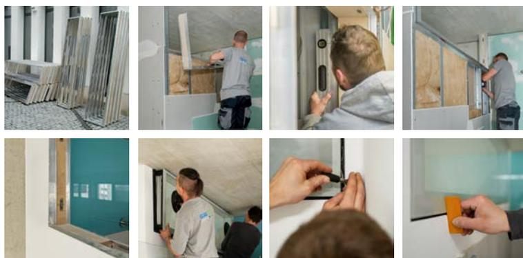
Planline pour pose à sec est **adapté au scénario temporel du second œuvre**. Le montage du système de châssis fourni auparavant se fait en même temps que le montage de la cloison sèche.
